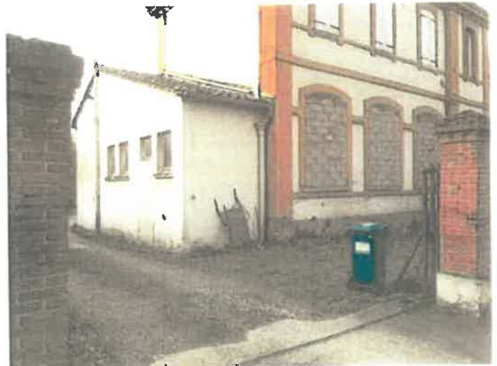
Portail d'accès avant
