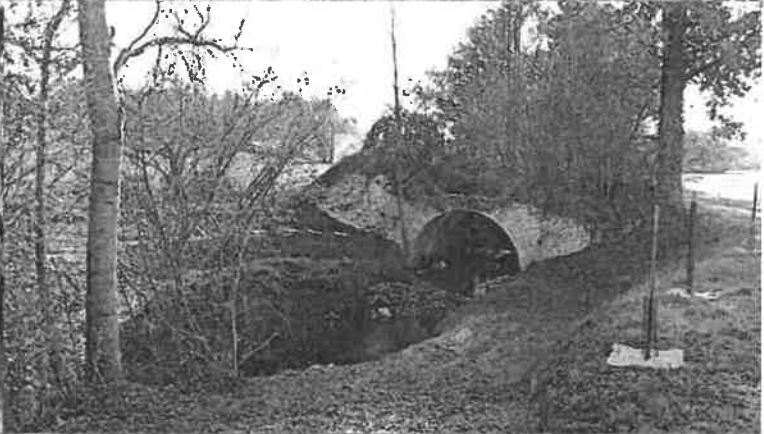
Pont mis en valeur après travaux – dec 2022
