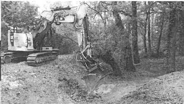
Travaux au niveau du bras du moulin – sept 2022
