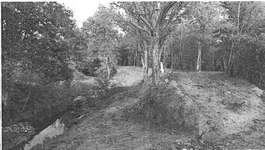
Après travaux – oct 2022
