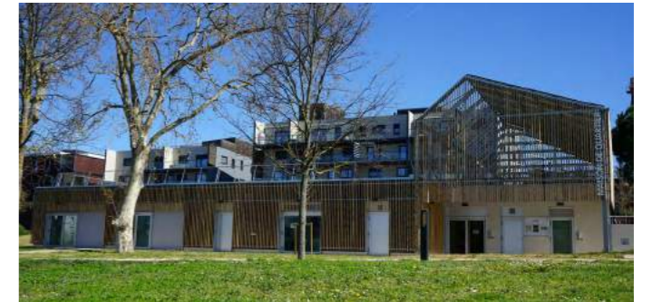
La nouvelle Maison de quartier : 400m 2 , en plein cœur du quartier, éco-responsable
